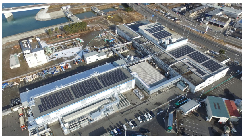
<石巻工場：383.68kW の自家消費型太陽光発電設備>
