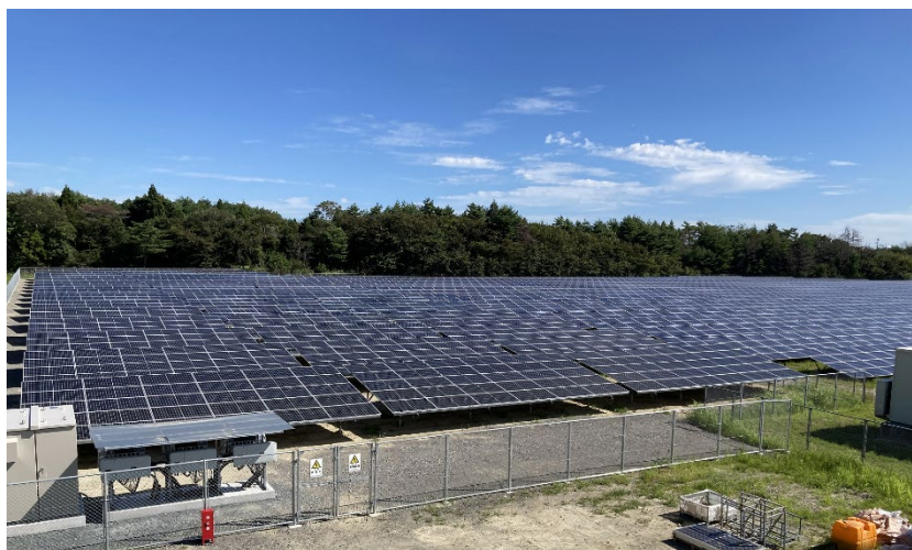
<福島工場：532.8kW の自家消費型太陽光発電設備とソーラーパーク福島>
