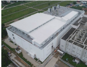
ベトナム第3工場
