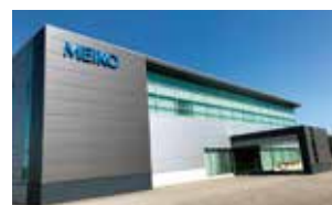
⑤ メイコーエンベデッドプロダクツ 本社・開発拠点 山形県米沢市アルカディア1丁目808-33
