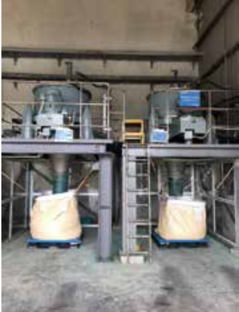
写真2:ベトナム工場の炭酸銅回収措置
