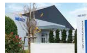
⑥ メイコーエンベデッドテクノロジー 本社 山形県南陽市漆山1305-1
