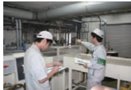
安全衛生委員による安全衛生パトロール
